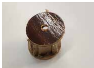
Foto nº2: Trozo del interior de una puerta hueca.
